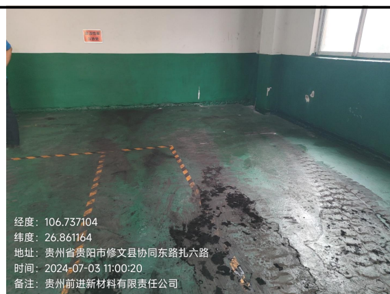
2 号危险废物暂存间防渗
