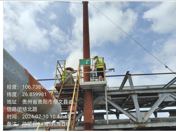
15m 高排气筒
