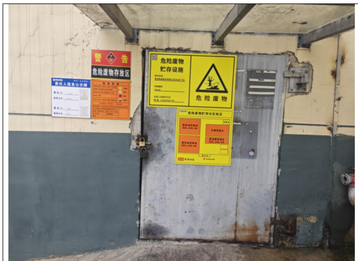
危废暂存间（废机油库）
